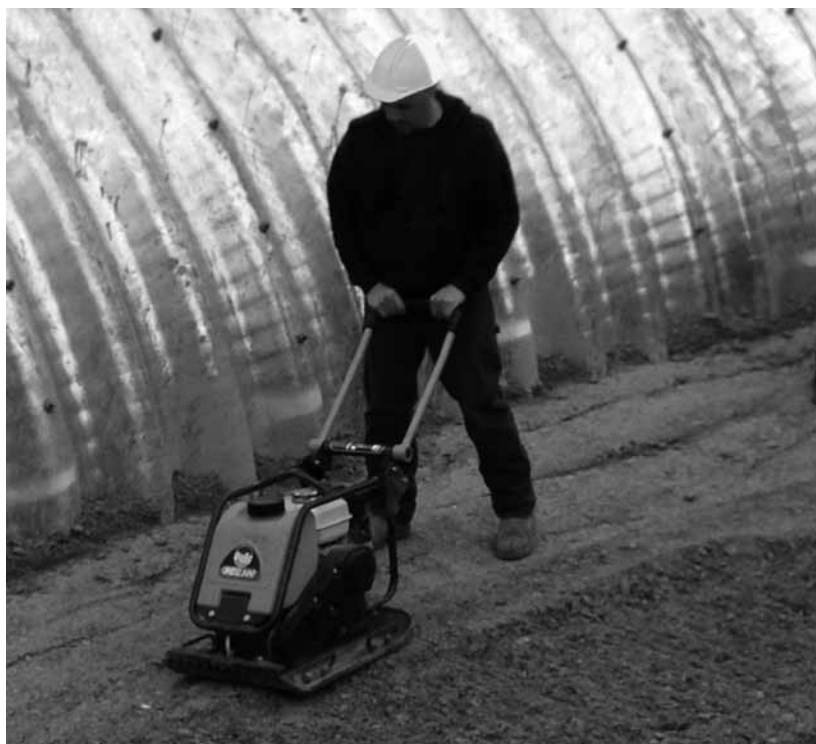
Figura 28. La compactación adecuada, uniforme es crítica en la construcción de suelos en las estructuras de acero.
