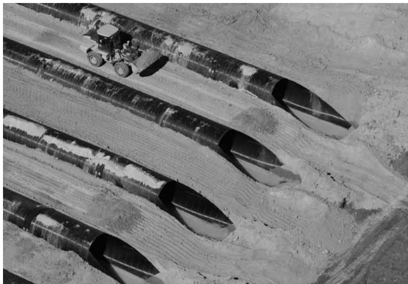
Figura 26. El relleno lateral compactado debe ser completado en ambos lados de la estructura antes de que el relleno sea “llevado” hacia la construcción del tráfico.
