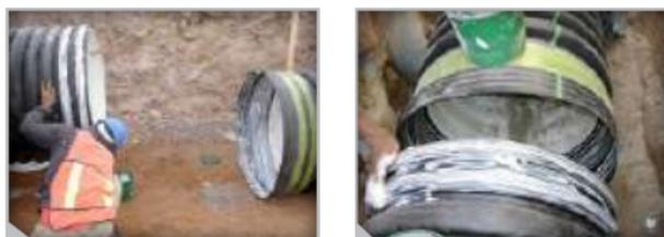
**Figura 10.** Limpieza en espiga e interior de campana y aplicación de lubricante.
