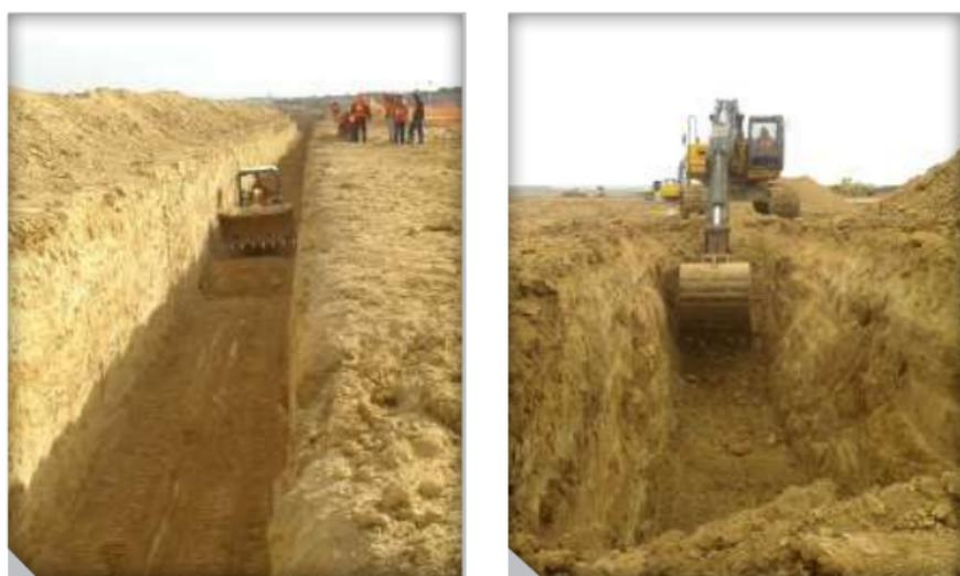
**Figura 5.** Excavación de la zanja.
