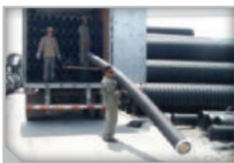
**Figura 1.** Descarga manual de tubería hasta 18 pulgadas.
