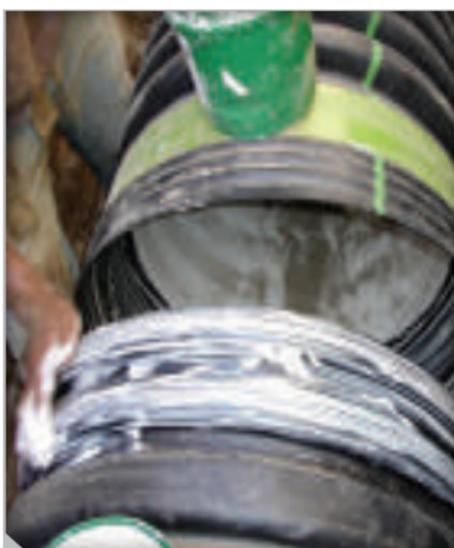
**Figura 14.** Colocación de lubricante.
