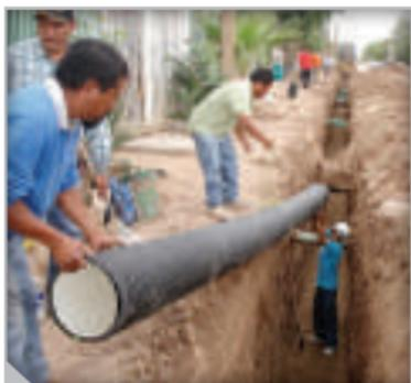
**Figura 8.** Bajado manual de tubería a la zanja.
