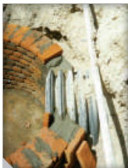
**Figura 20.** Conexión a pozo con empaques de valle.
