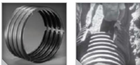
Figura 25. Instalación de cople abierto.
