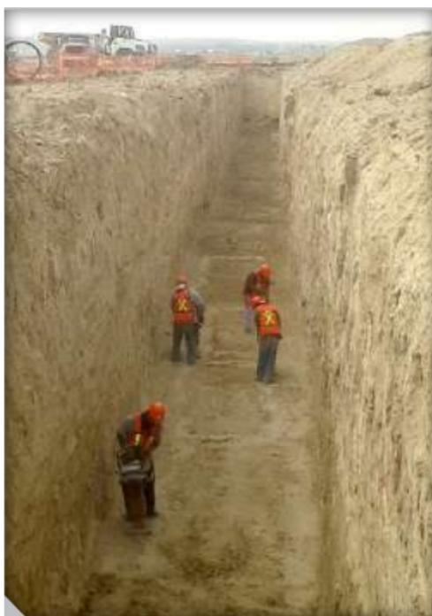
**Figura 7.** Compactación de encamado con equipo portátil.
