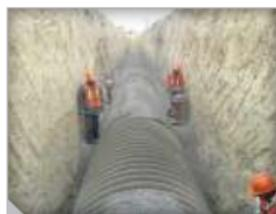
**Figura 16.** Colocación y compactación simétrica por capas.
